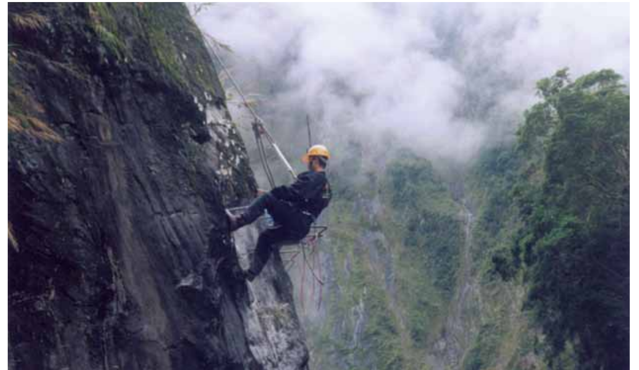
南溪壩施工棧道鋼筋孔鑽設
