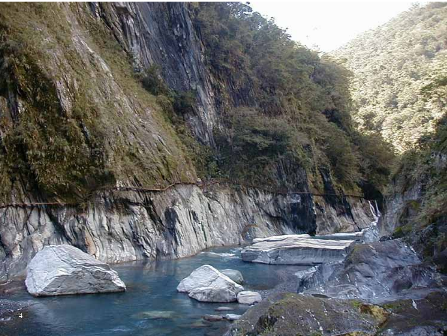
南溪壩施工棧道
