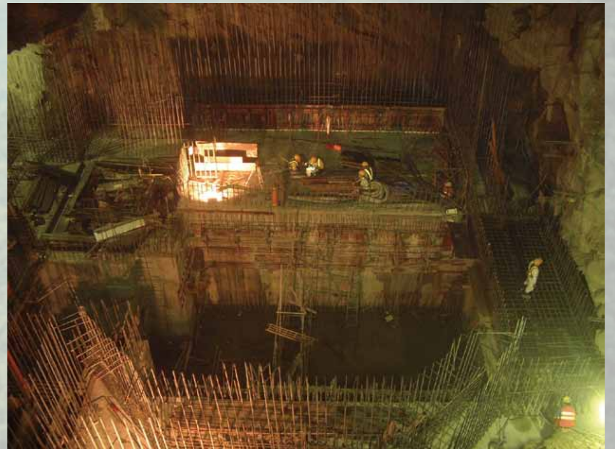
地下廠房機組間襯砌施工
