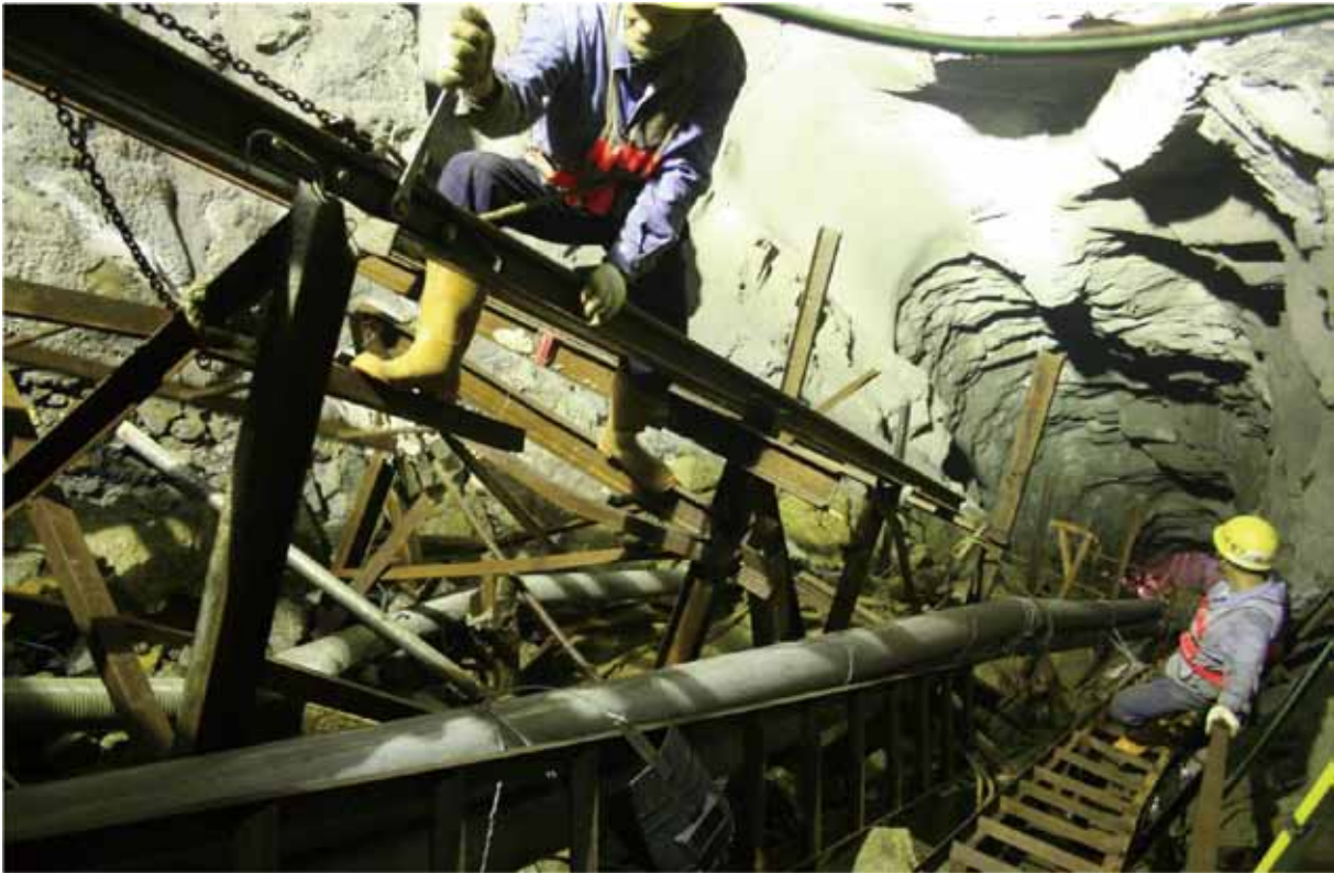
台電人員進行壓力鋼管路的鋼軌修護
