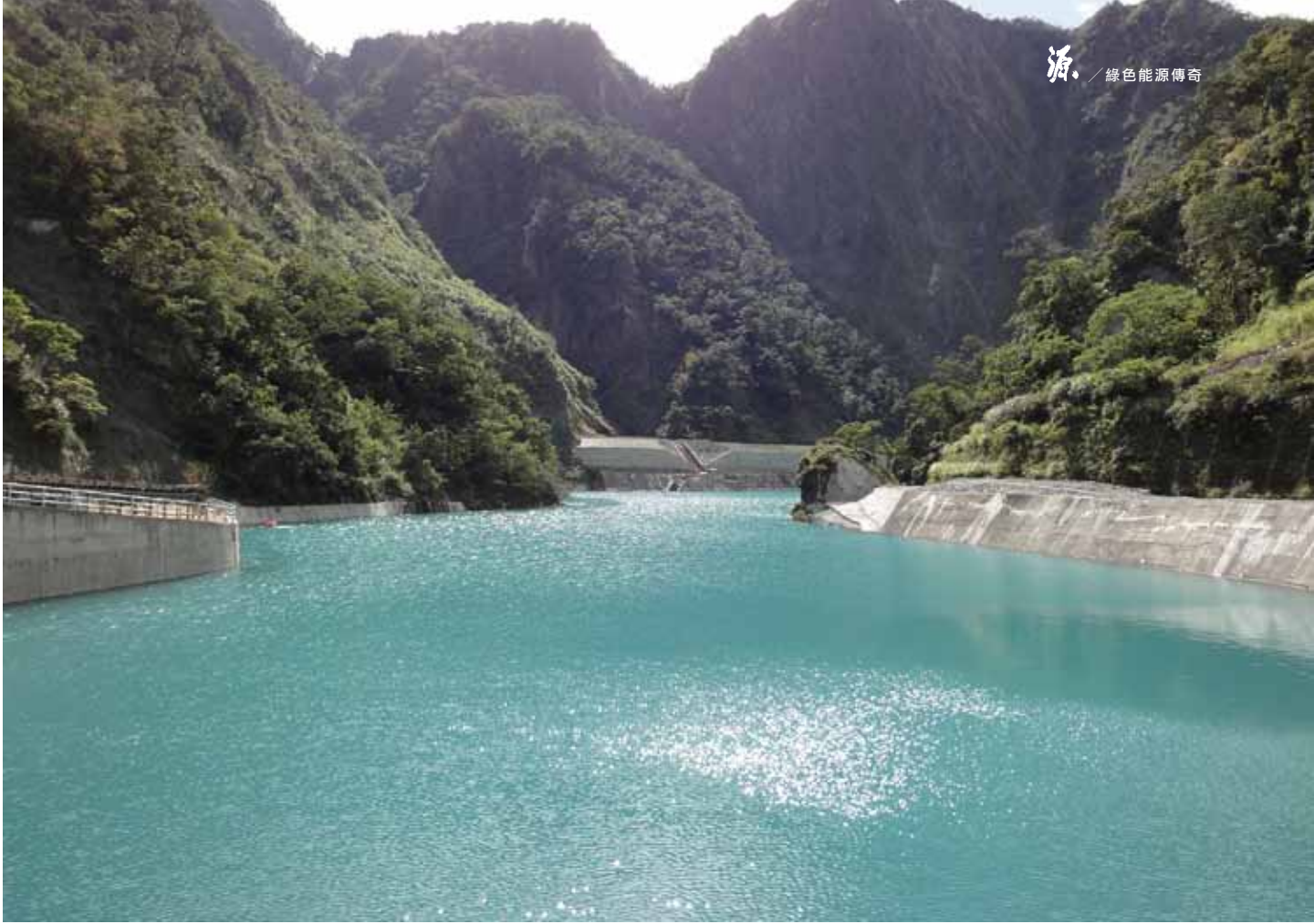
南溪壩蓄水情形
