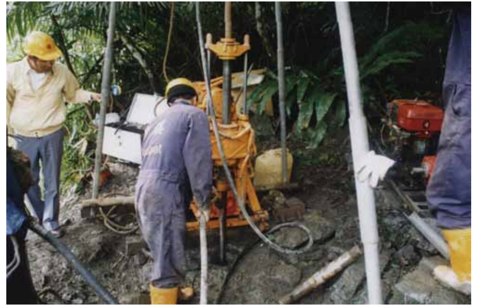
施工道路地質鑽探
