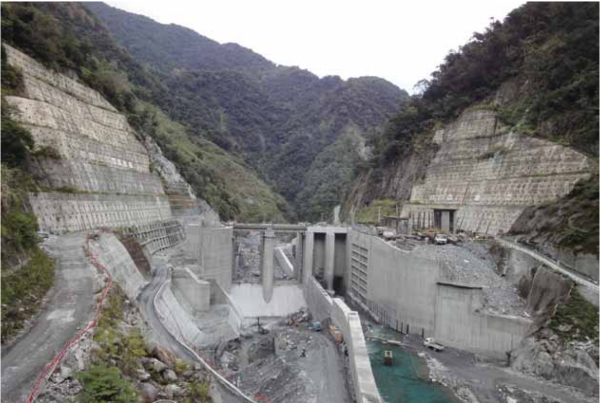
南溪壩施作全景
